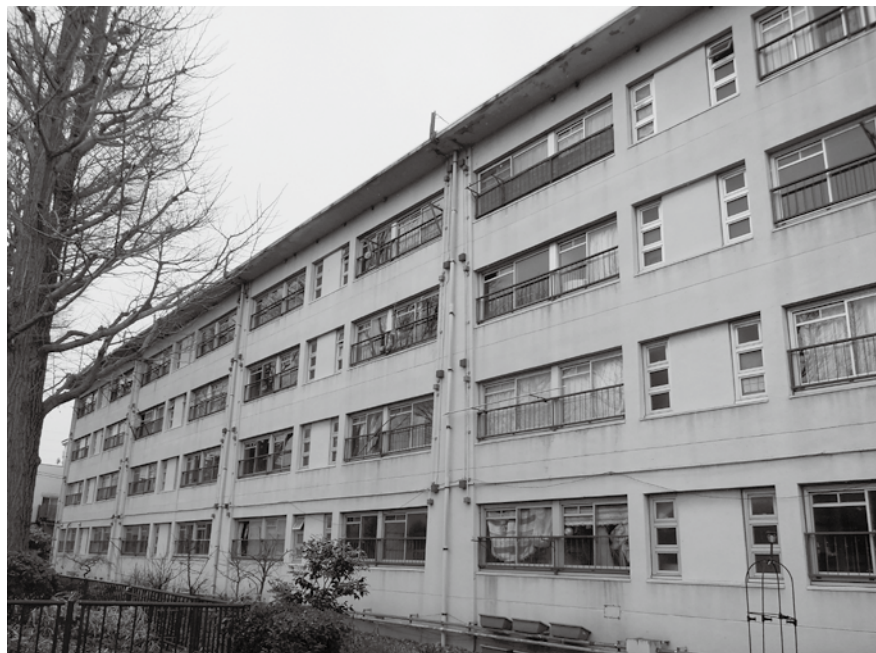
真っ先に廃止検討の対象とされた仙台市青葉区の中江東県営住宅
